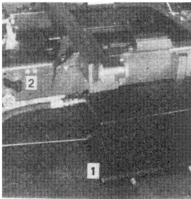
Bild 19 (4x4) Bild 20 (4x2) (1) Batteriekasten (2) Hauptschalter
